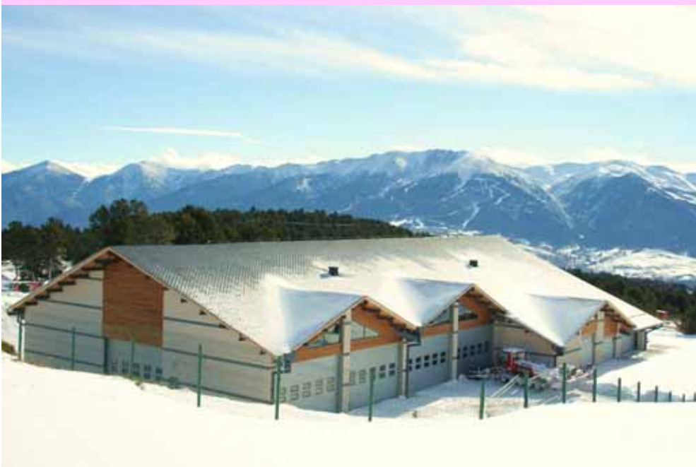
La nouvelle zone technique des Airelles
