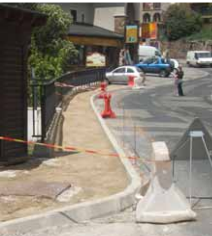
Rénovation du trottoir longeant le Chalet St Georges
